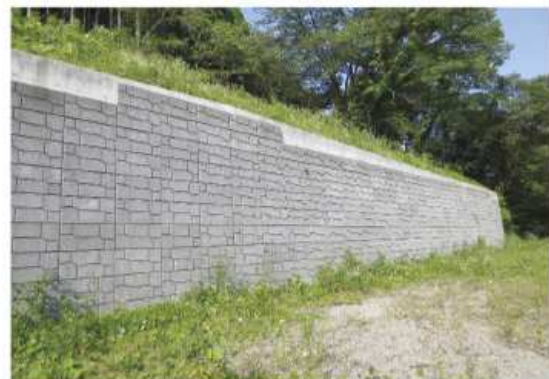
震度6弱 最大高さH=6.7m土羽付き 異常なし
