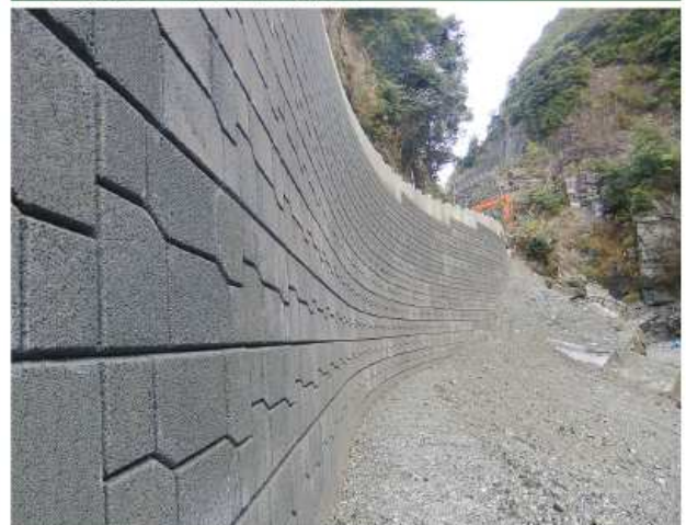
山間部道路拡幅 護岸工
