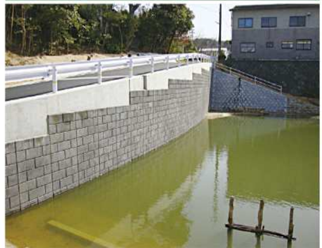
道路拡幅 護岸工
