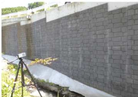
震度6強 最大高さH=7.2m 異常なし
