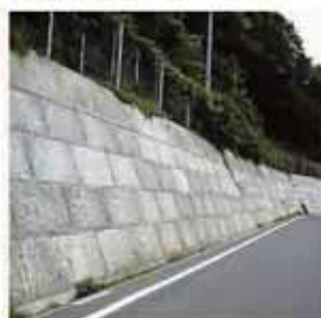
道路改良工事
