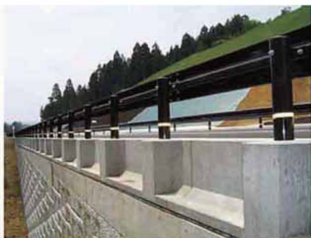
補強土壁直上
