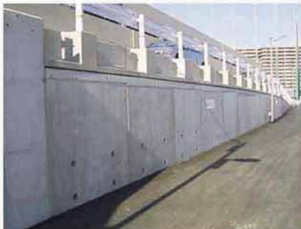
プレキャストL型擁壁直上
