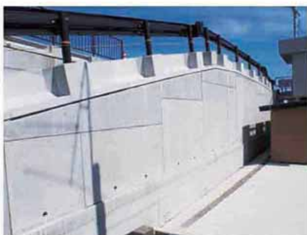
勾配変化部設置
