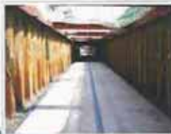
基礎コンクリート上に マルチ走行ガイドを設置
