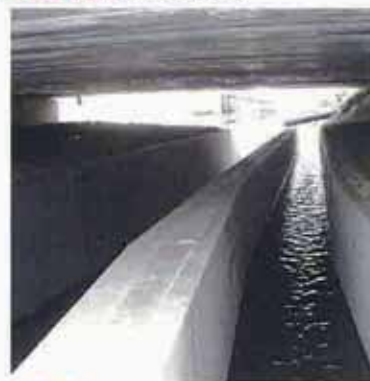
高架下での大型フリーム搬送・据付け工法
