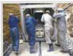
▲ボックスカルバート据付作業 左右位置調整作業
