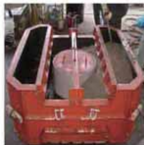
②コンクリート打設
