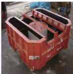
①型枠組立
